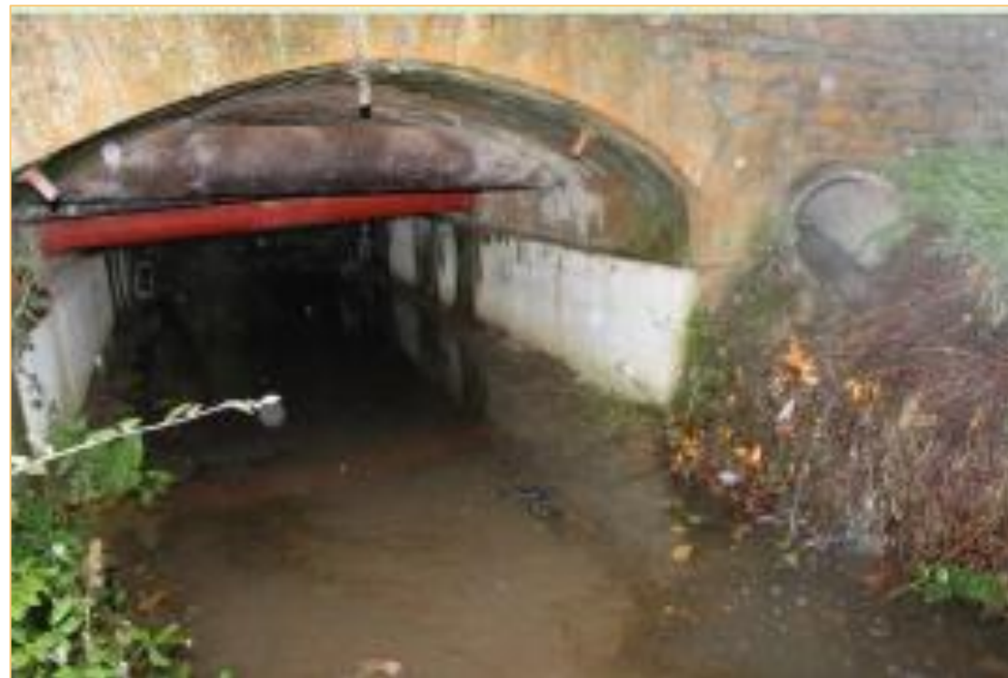
Sous le pont de la route de Charnay (RD70E)
