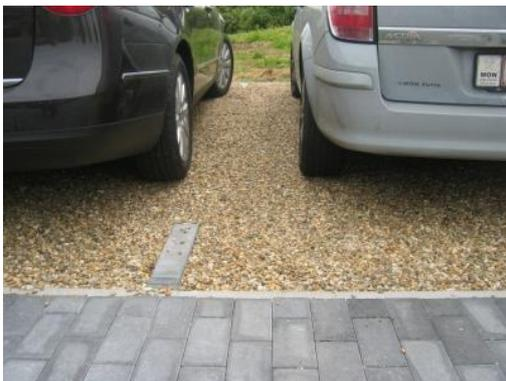
**Exemple de stationnements en revêtement perméable**
